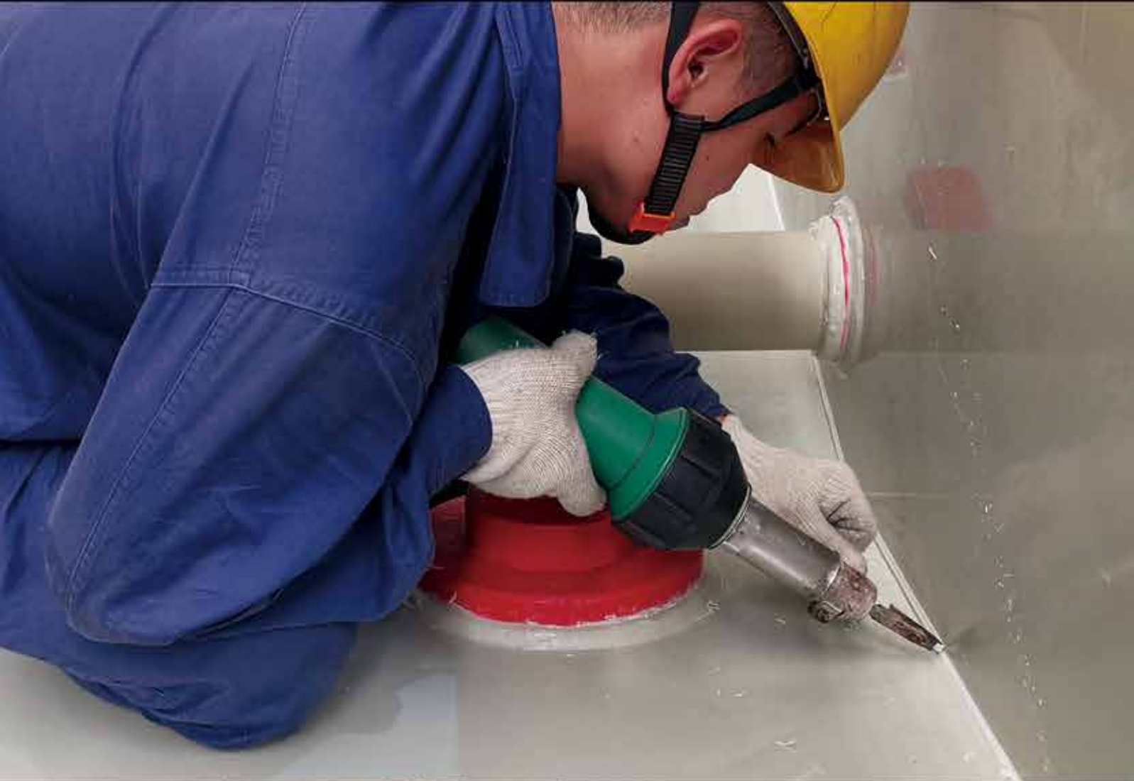
▲ 车厢内衬PP板材焊接 LST1600S
