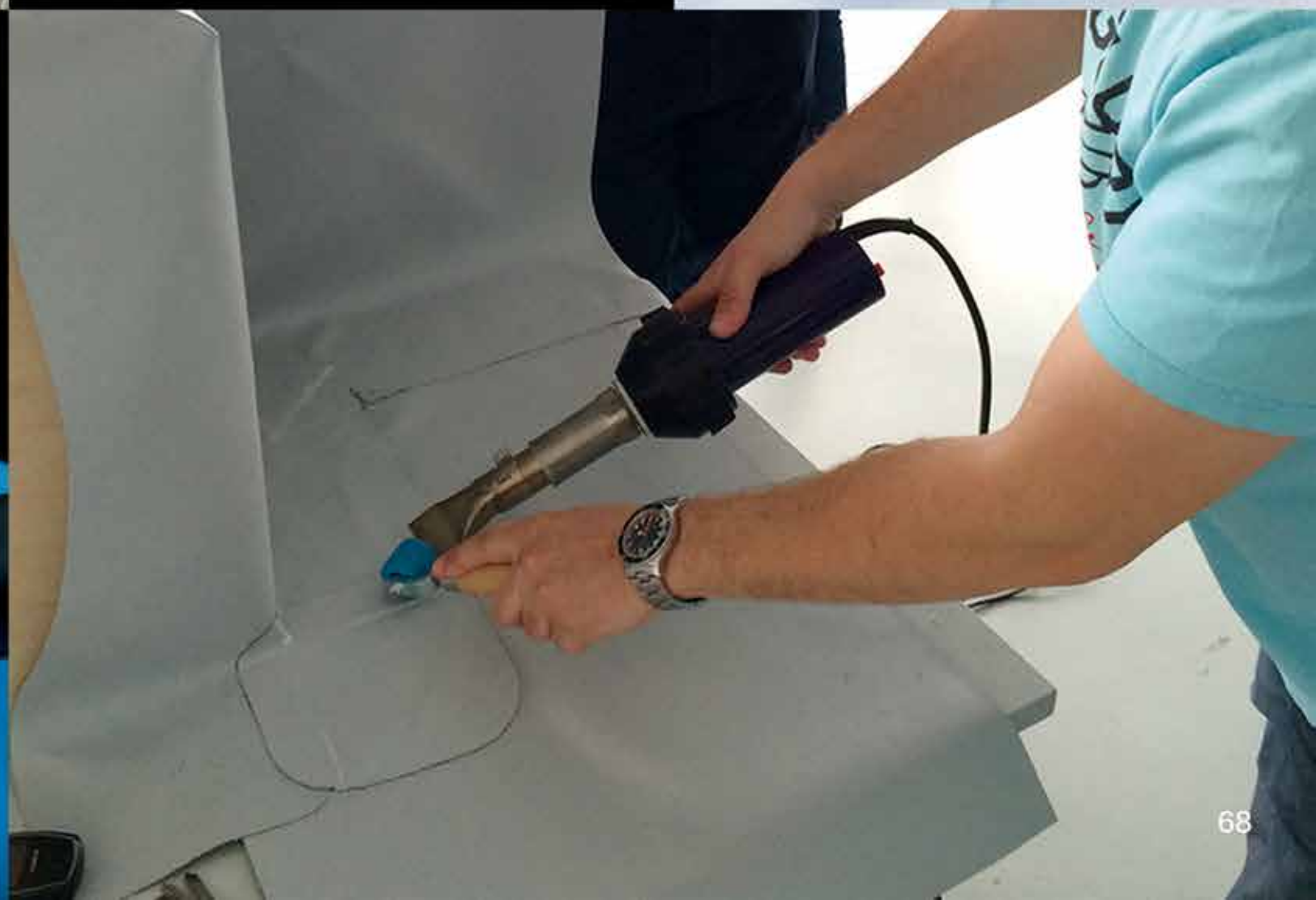
▼ 屋面TPO材料阴阳角修补焊接 LST1600A
