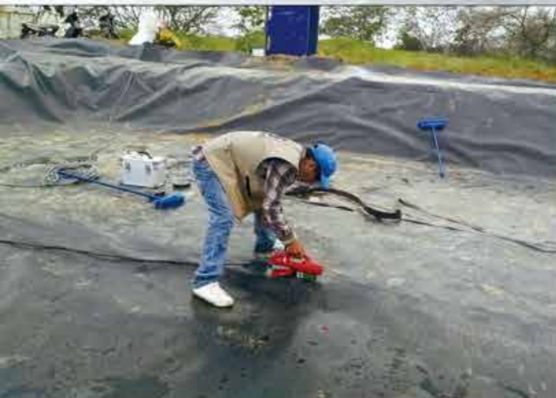
▲ HDPE (1.0mm) 膜材焊接, 人工湖项目 LST800D
