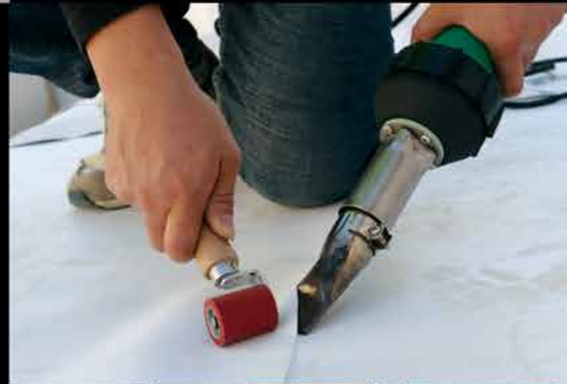
▼ 屋面TPO材料的局部焊接 LST1600S
