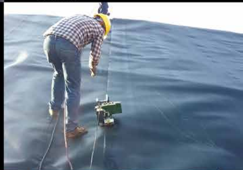
▼ HDPE (1.5mm) 膜材焊接, 尾矿现场 LST-GM1
