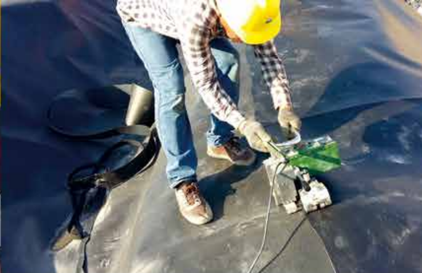
▲ HDPE (2.0mm) 膜材焊接, 垃圾填埋场 LST900
