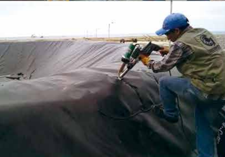
▲ 土工膜的修补焊接 LST610B
