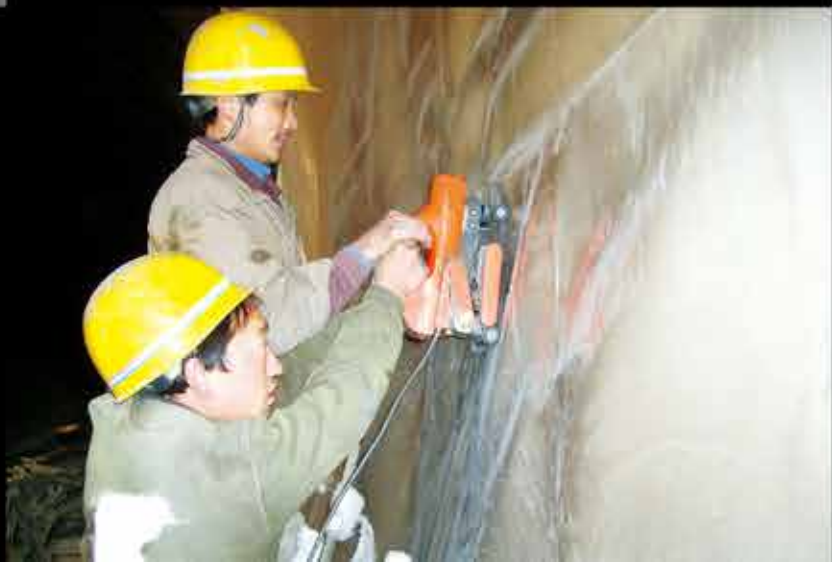
▼ 隧道防水板焊接 LST800
