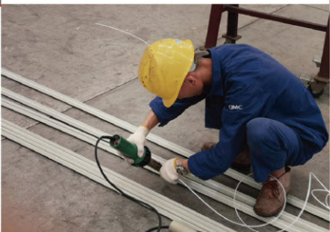
PP 塑料型材的焊接 LST1600S
