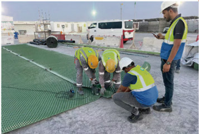
HDPE(2.5mm) 隧道排水板焊接 LST900
