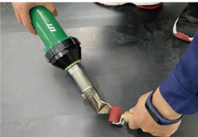
土工膜的修补焊接 LST1600A
