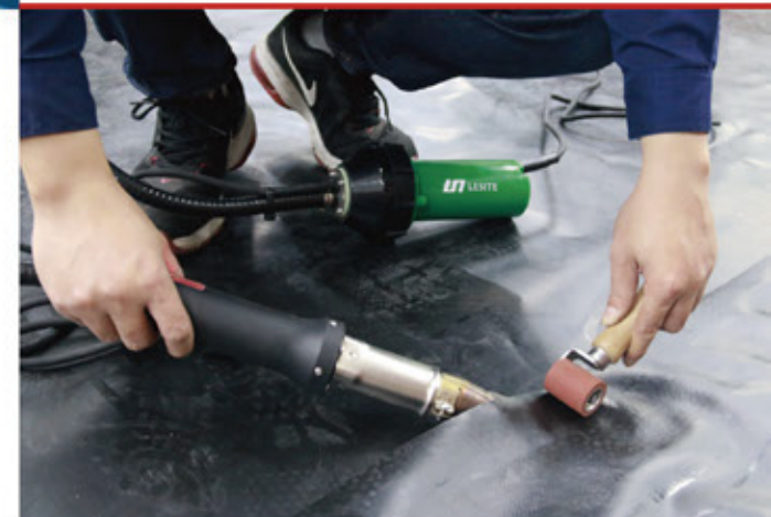
土工膜的修补焊接 LST2000
