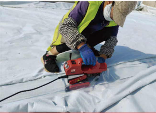
两布一膜复合膜焊接 LST800D
