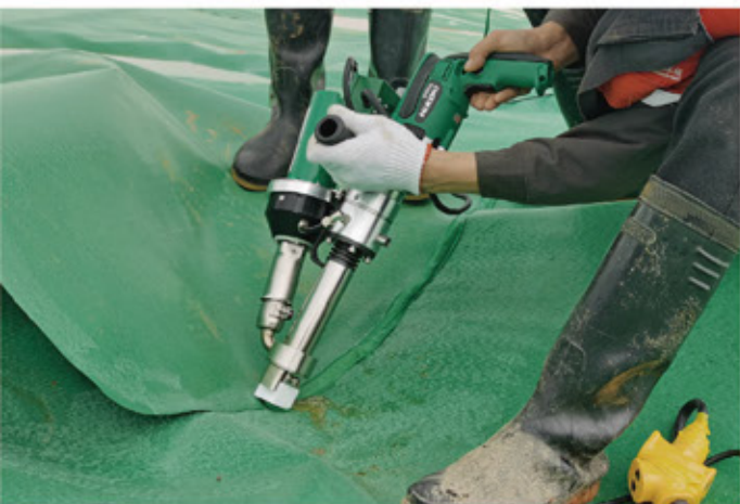
土工膜的修补焊接 LST600A
