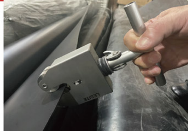
HDPE 膜材铺设 LST-PULLER 1
