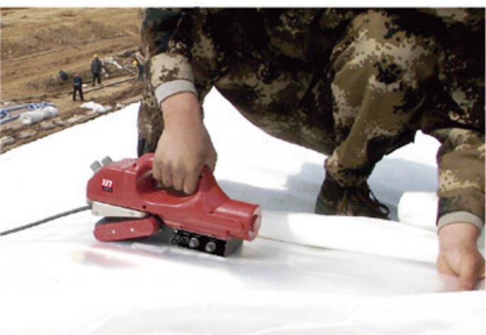
复合土工膜材料焊接 LST800
